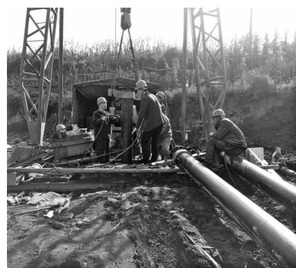
图4 水泵安装现场
