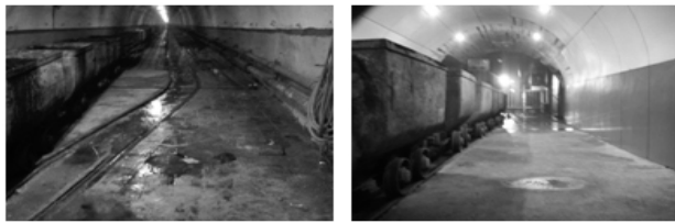
图7 实施反底拱锚固梁2a后的底板支护效果图
